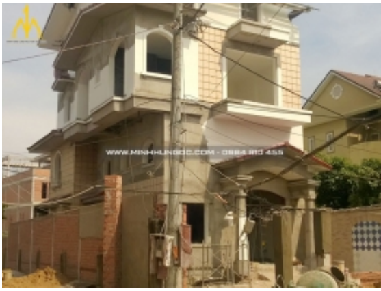
Nhà chị Mai - Quận Thủ Đức
