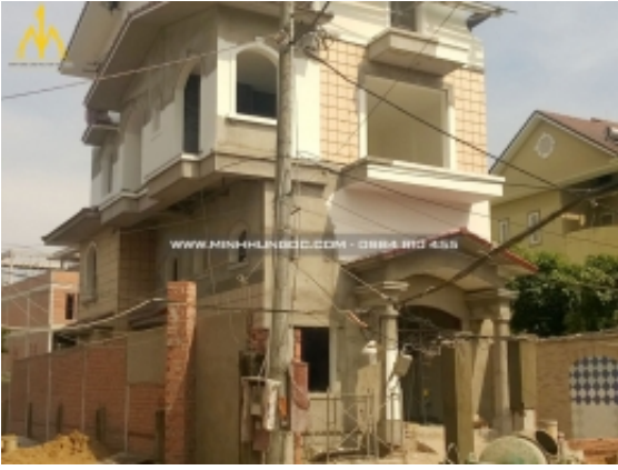
Nhà chị Mai - Quận Thủ Đức
