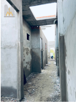
THI CÔNG NHÀ VƯỜN MÁI THÁI TẠI BÌNH NHÂM - BÌNH DƯƠNG
