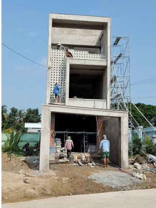
Thi công công trình nhà phố ở Tân Ba Bình Dương
