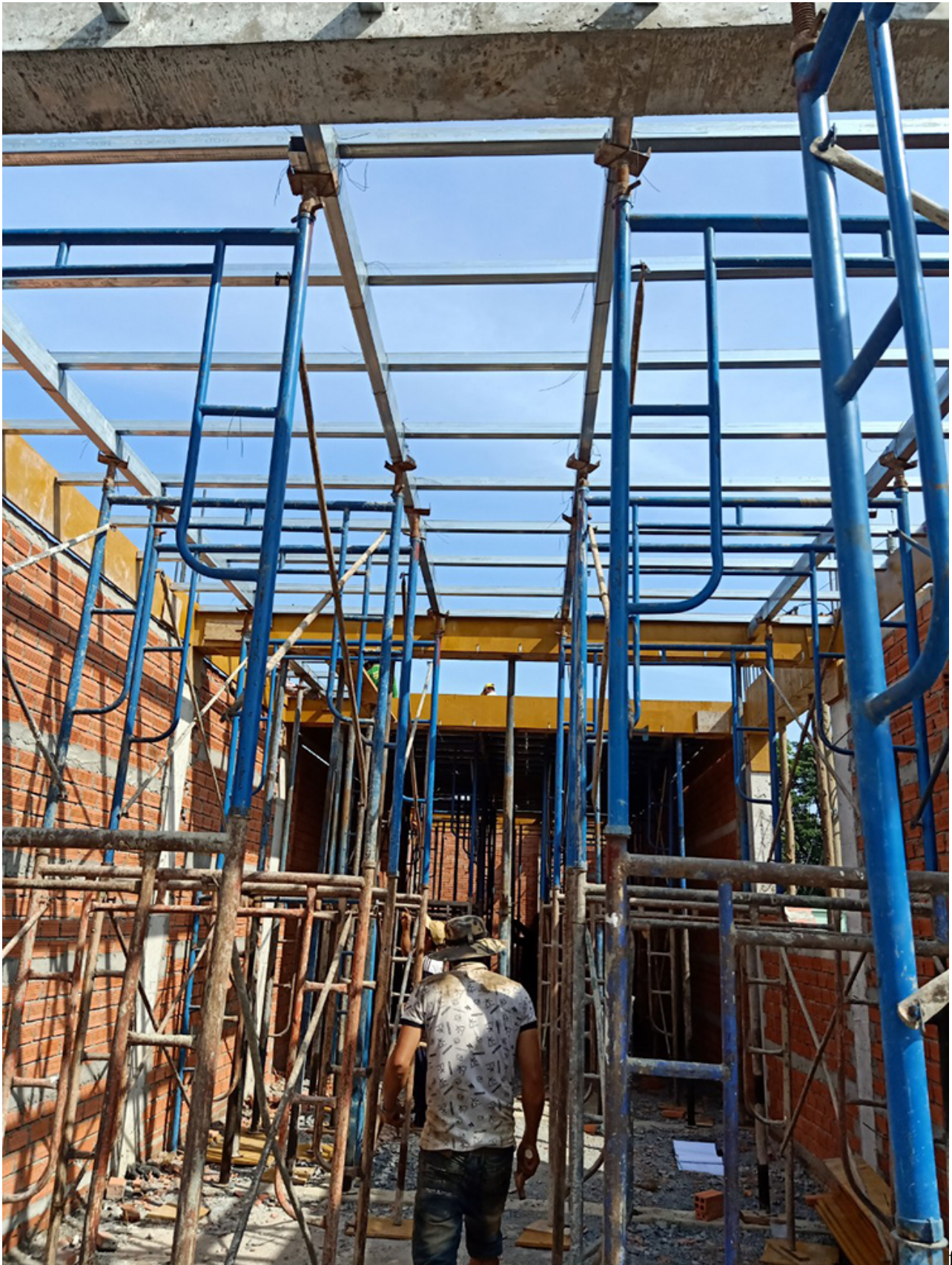
Công tác cốt pha sàn
