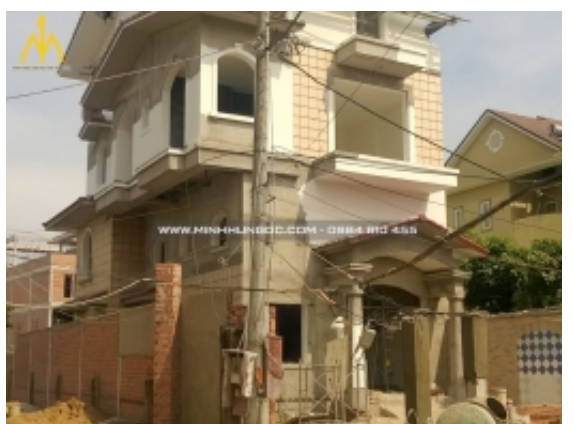
Nhà chị Mai - Quận Thủ Đức
