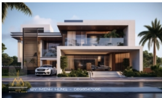
MẪU THIẾT KẾ BIỆT THỰ HIỆN ĐẠI 2023 BTHĐ-MH04
