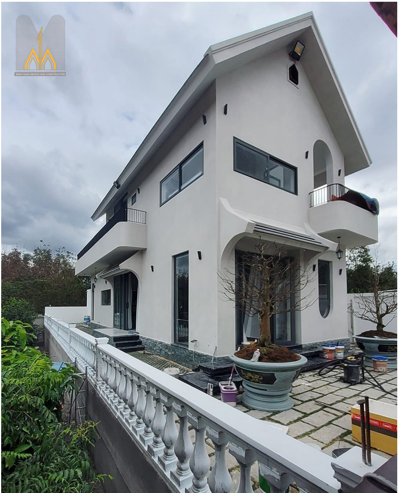
Hình ảnh do Minh Hưng thiết kế và thi công
