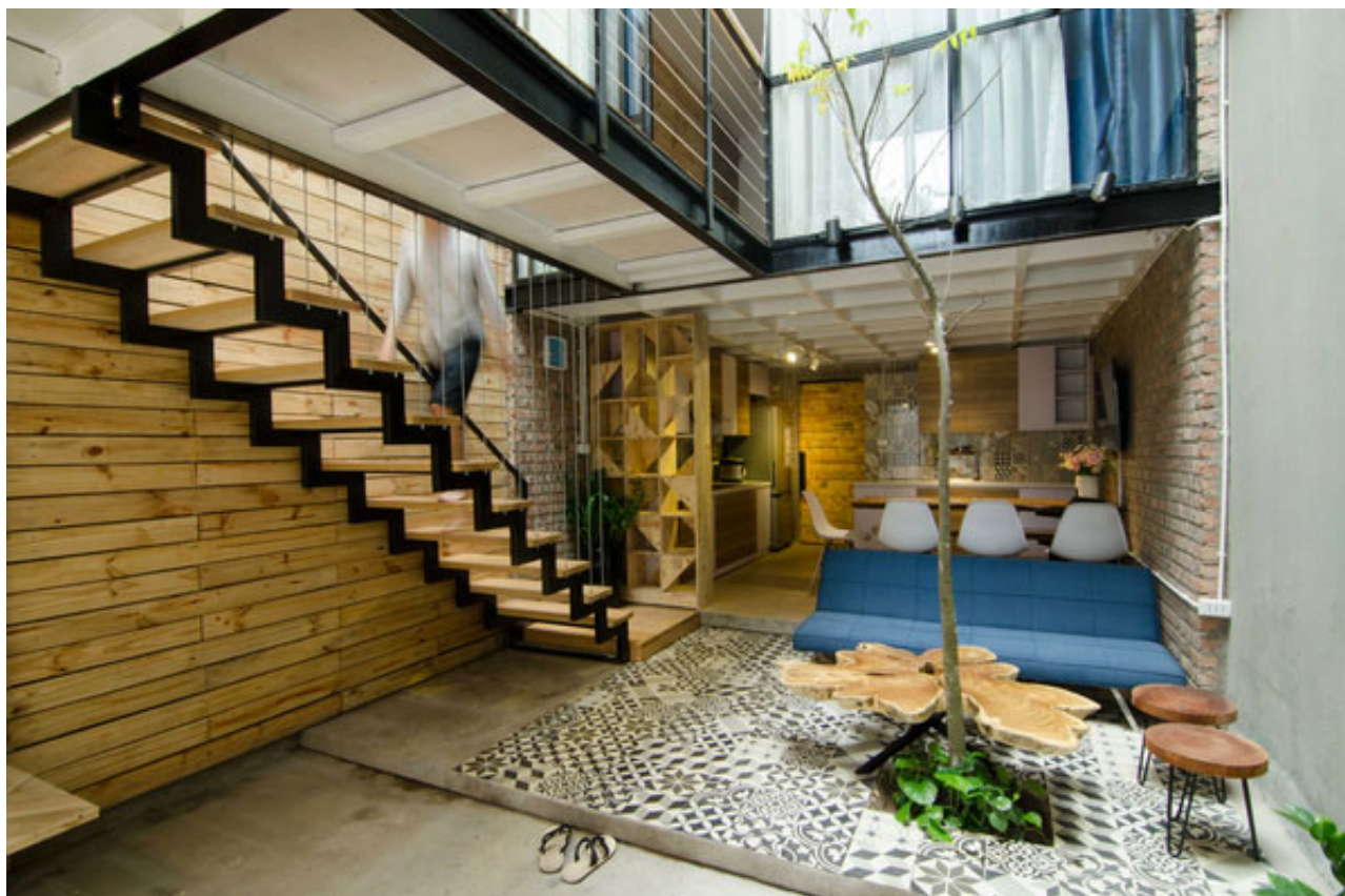
Cầu thang mặt gỗ tự nhiên kết hợp với sắt hộp cực hợp cho nhà nhỏ.
